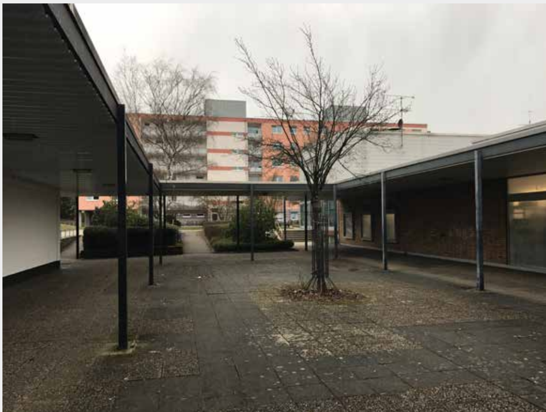
Abbildung 92: Dalheim-Zentrum , Quelle: NH ProjektStadt (2017)
