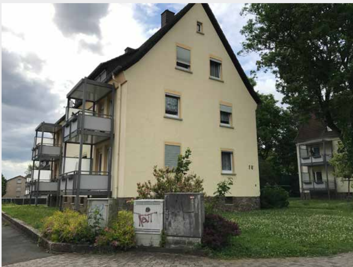
Abbildung 29: Nachträglicher Balkonanbau, Quelle: NH ProjektStadt (2017)
