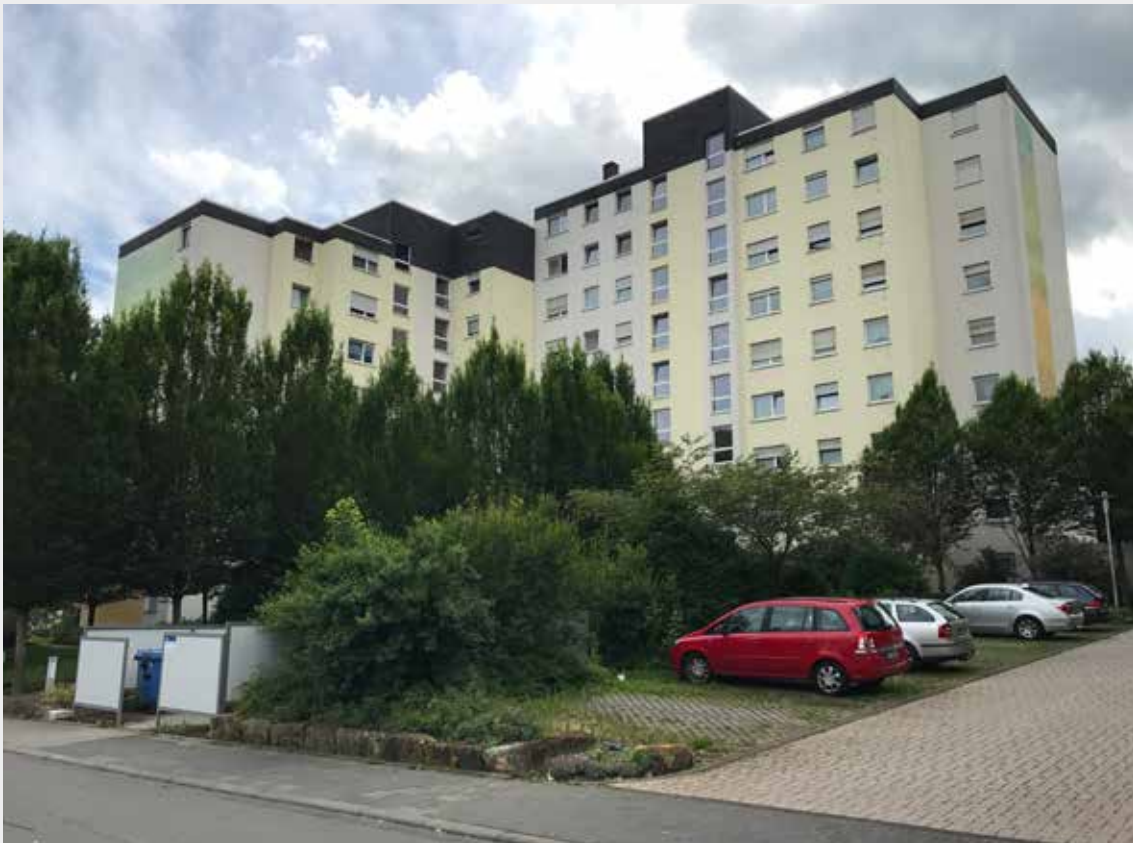
Abbildung 17: Mehrfamilienhäuser, Quelle: NH ProjektStadt (2017)
