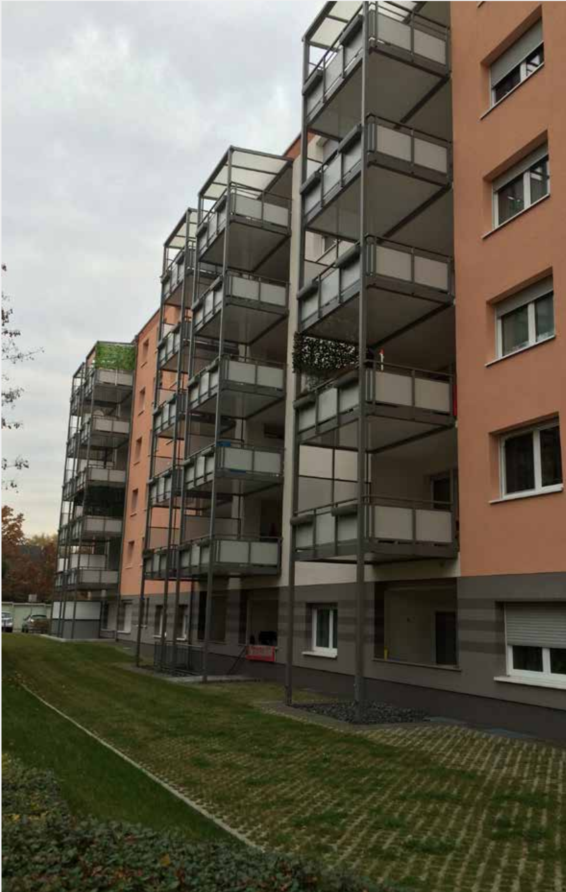
Abbildung 30: Nachträglicher Balkonanbau, Quelle: NH ProjektStadt (2017)
