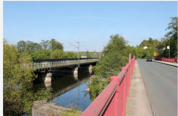
Abb. 36: Brücke an der Rittal Arena
