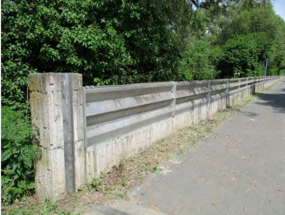
Abb. 96: Hochwasserschutzwand
