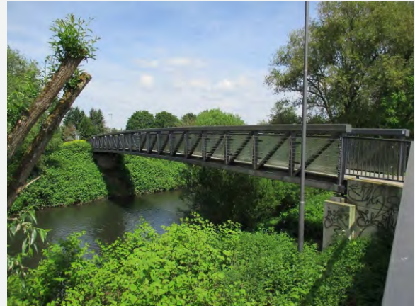
Abb. 89: Brücke ins Bodenfeld
