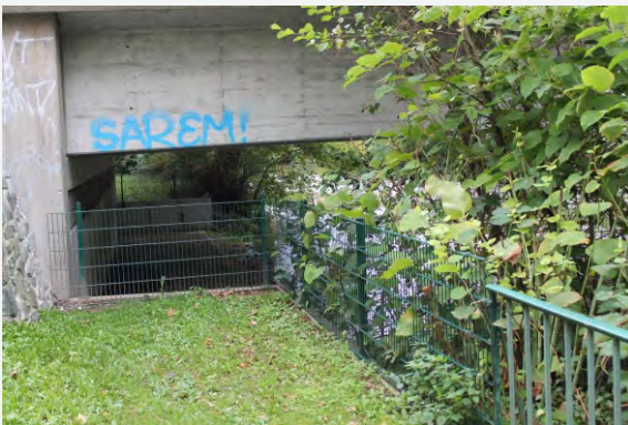
Abb. 47: Hausertorbrücke mit Aussparung für Radweg
