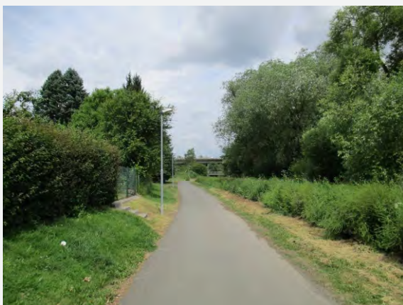
Abb. 93: Radweg in Richtung Dillfeld
