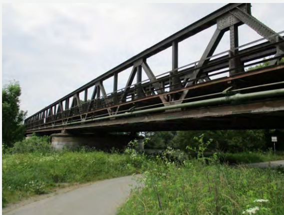
Abb. 100: Eisenbahnbrücke Blick in Richtung Westend
