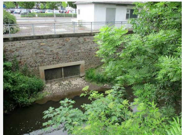
Abb. 74: Einlaufbauwerk in der Nähe der Einmündung des Wetzaches in den Mühlgraben.
