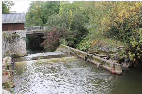
Abb. 71: Wasserkraftwerk am Muhlgraben
