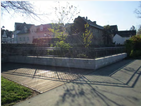
Abb. 73: Neugestaltung Ufermauer und Geländer am Wetzbach
