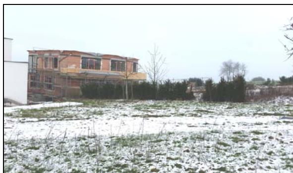
Abb. 3: Blick über das Plangebiet von Süd nach Nord. Im Hintergrund: Wohnbebauung (im Bau).
