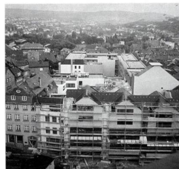
Abb. 27 Bau Stadthaus am Dom
