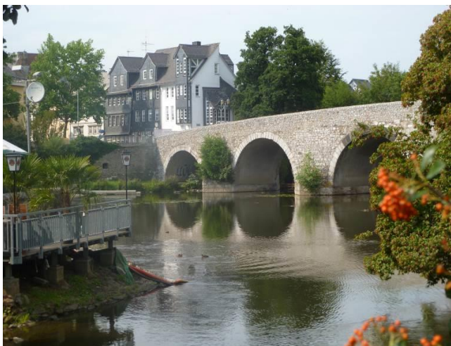
Abb. 41 Blick Richtung Langgasse auf die Alte Lahnbrücke
