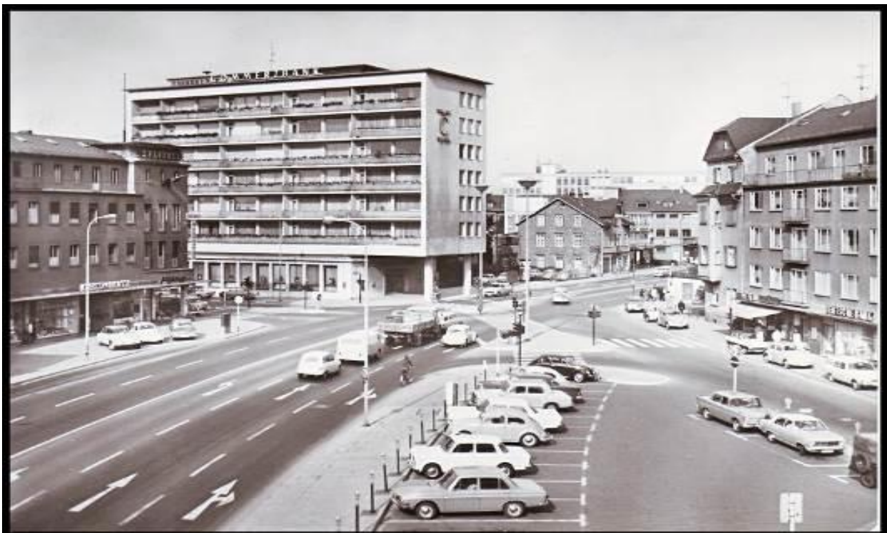
Abb. 24 Autogerechte Straßenräume Kreuzungspunkt Karl-Kellner-Ring - Sophienstraße
