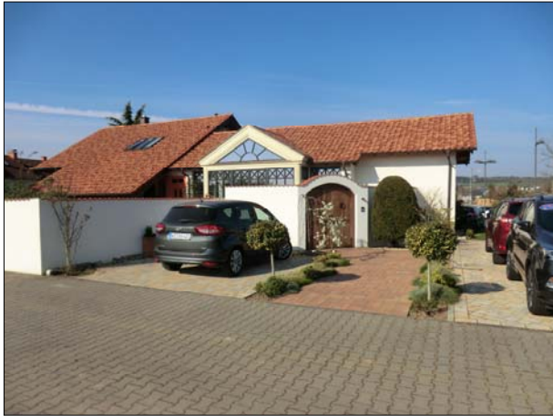
Abb. 8: Wohngebäude im Plangebiet
