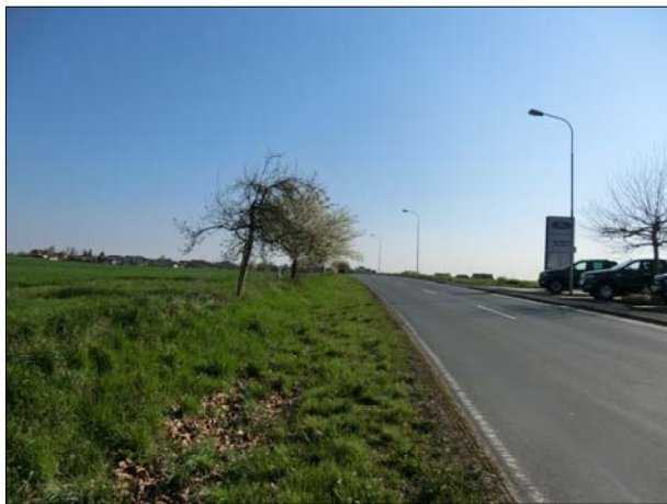
Abb. 4: Abschnitt der Kreisstraße im Plangebiet.
