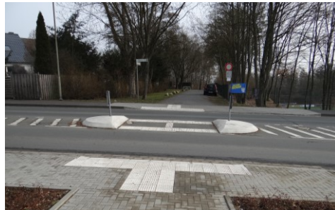
Good Practice: Mittelinsel über Hohe Straße
