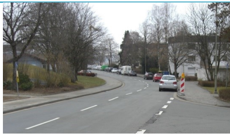
Fehlende Querungsanlage über Berliner Ring
